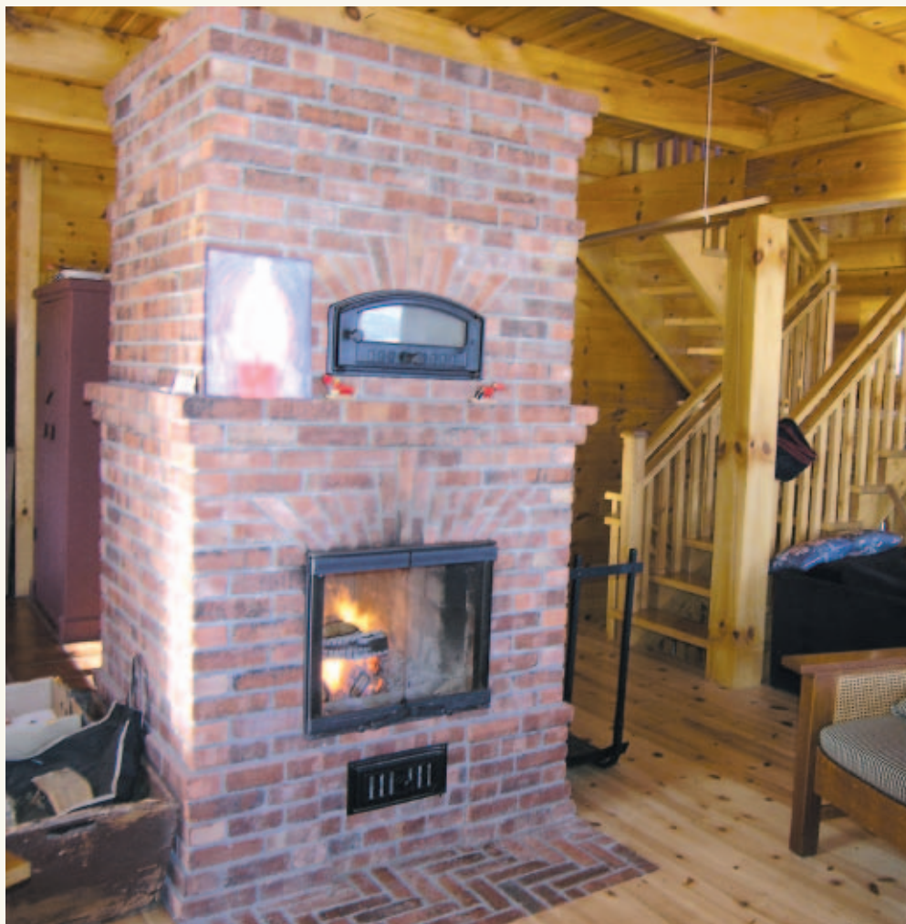
Le foyer de masse du chalet a été construit par Marcus Flynn avec des briques de récupération datant de plus de 100 ans; les propriétés plastiques (expansion et contraction) de celles-ci seraient meilleures que celles des briques fabriquées plus récemment.
